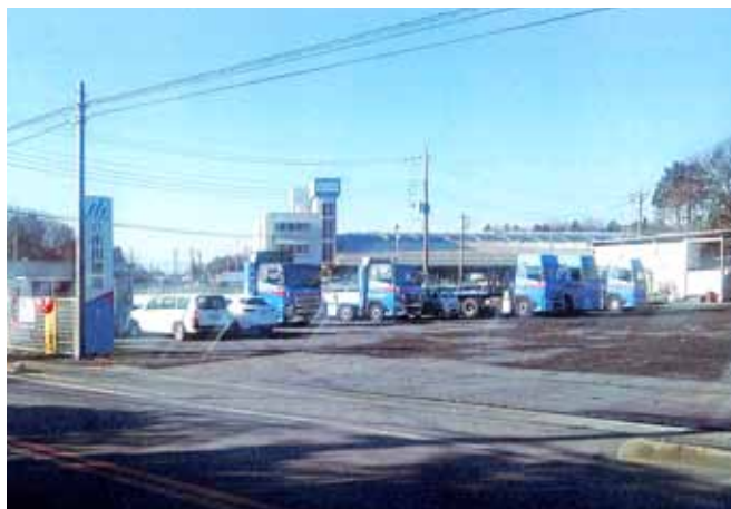
玉田工業工場(株)関東工場内で 大型地下オイルタンク積載(120KL)
