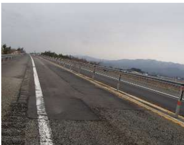
舗装路面の状況
