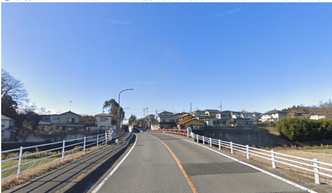
②宇都宮テクノ街道から西川橋(平出工業団地方面)へ向かう道路↓
