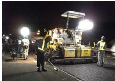
舗装補修工事 作業状況
